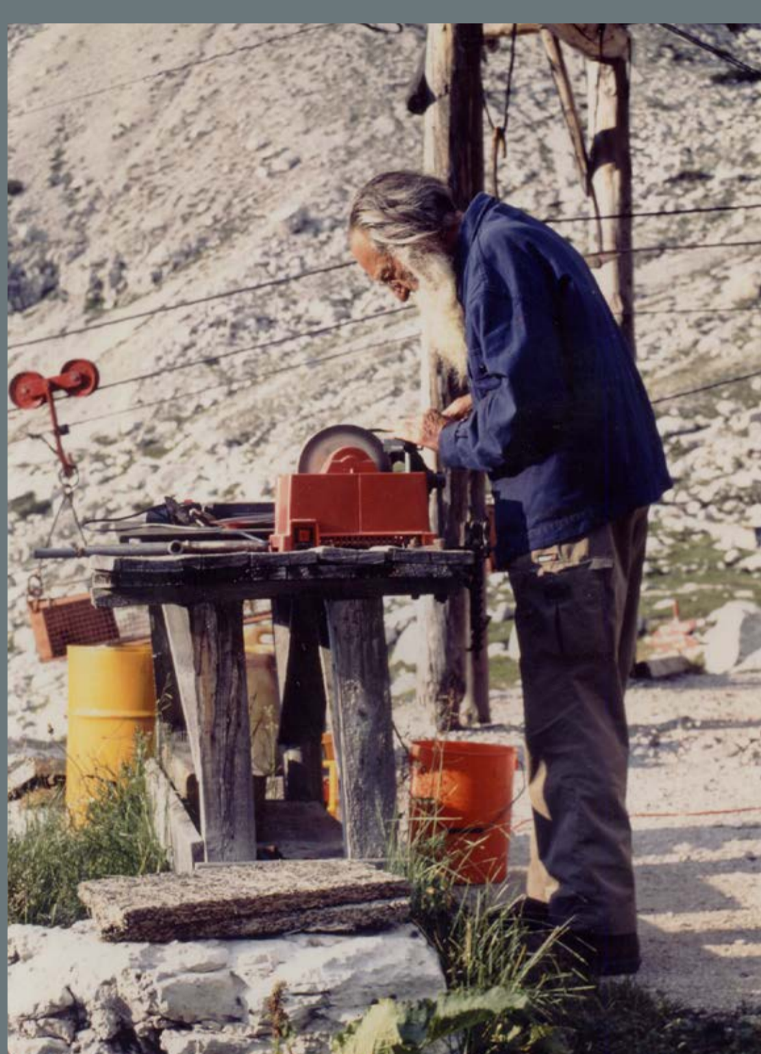
Bruno Detassis impegnato in lavori di manutenzione al rifugio Brentei
