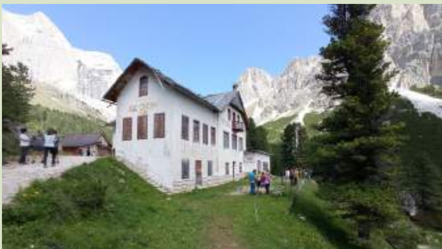
Il rifugio Catinaccio, caso studio considerato durante il laboratorio progettuale
