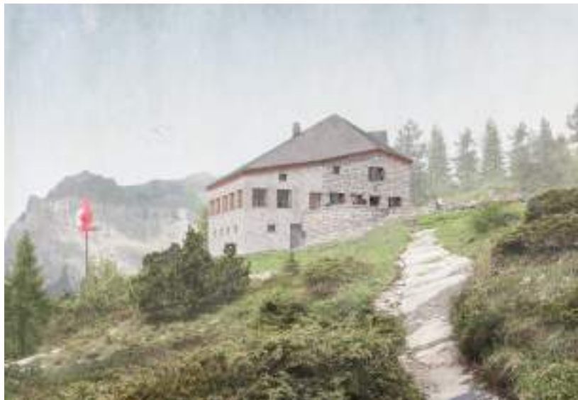
Doldenhornhütte SAC (Rifugio Doldenhorn CAS, Alpi Bernesi) © Seiler Linhart Architekten Committente: CAS sezione Emmental. Progettisti: Seiler Linhart Architekten, Sarnen Trasformazione e ingrandimento: concorso 2022, realizzazione 2025
