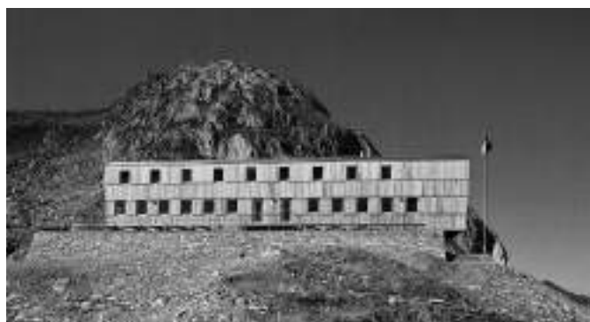
Capanna Cristallina, Vista Sud
