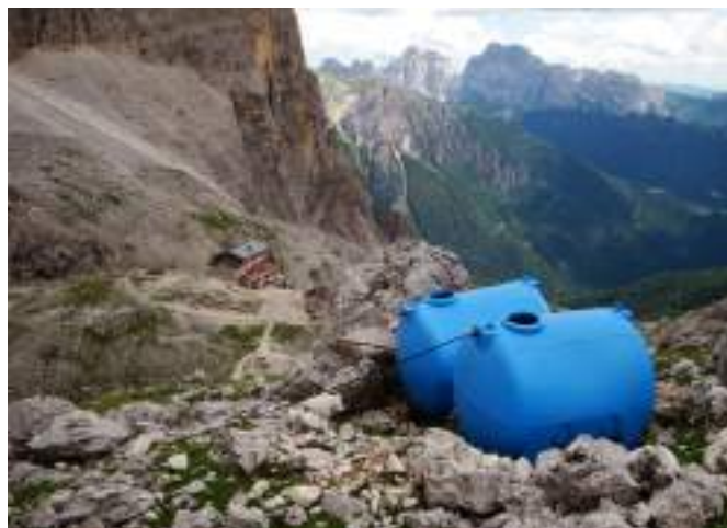
Rifugio Pradidali, la posizione delle vasche di accumulo rispetto al rifugio
