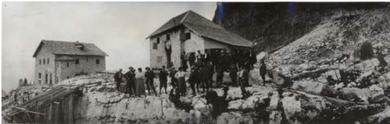
1906: inaugurazione del rifugio Quintino Sella nella Dolomiti di Brenta (2272 m) ad opera della SAT, mentre, in secondo piano, si sta ultimando il cantiere del rifugio Francis Fox Tuckett ad opera del DOAV di Berlino, Biblioteca della montagna - Archivio storico SAT
