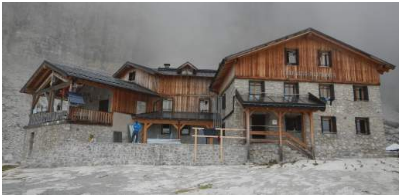
Rifugio Alimonta, esempio di rifugio con vasca per l'accumulo dell'acqua piovana sotto la terrazza esterna
