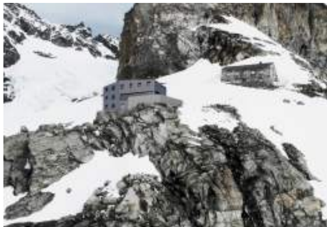
Rothornhütte SAC (Rifugio Rothorn CAS, Alpi Vallesane) © Arnold Zurniwen Architekten Committente: CAS sezione Monte Rosa. Progettisti: Arnold Zurniwen Architekten, Zermatt Demolizione capanna fatiscante esistente, sostituzione: progetto 2016, realizzazione 2023
