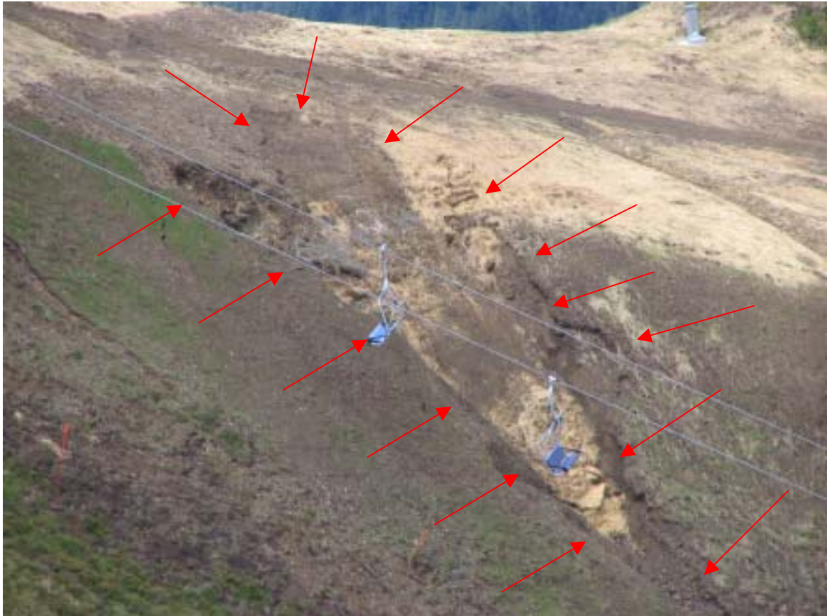
Foto 3) 2/7/2005 cedimento di discrete dimensioni della scarpata di valle sotto Col de Valvacin e colata fangosa
