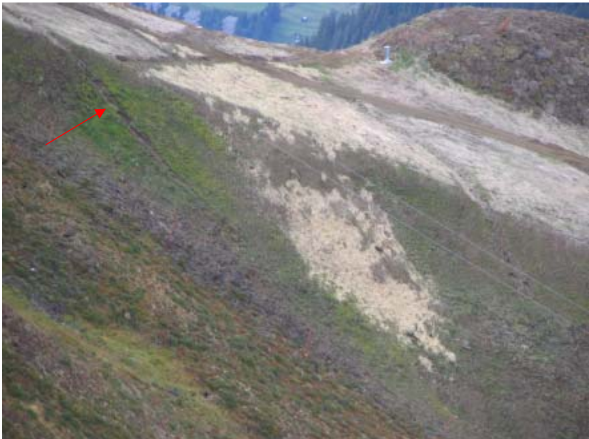
Foto 4) 24/9/2005 stessa colata risistemata, ancora presenti però i fenomeni di ruscellamento a monte
