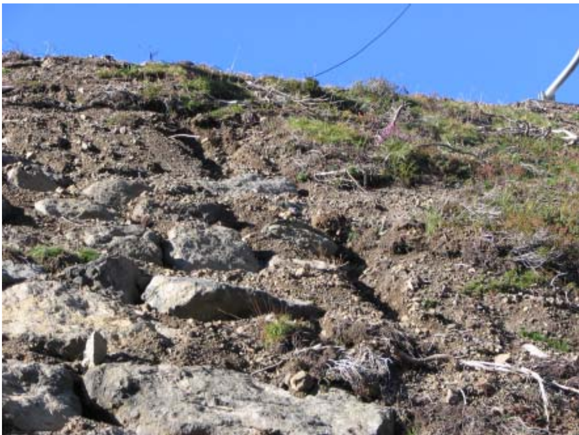
Foto 22) 24/9/2005 Loc Svarvazen Canali di erosione e rododendri secchi e facilmente divelti
