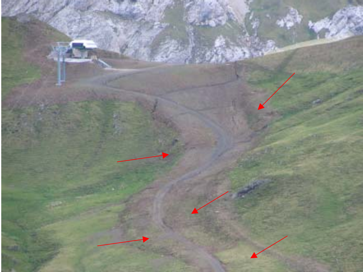
Foto 14) 2/7/2005 Sella del Brunech, solo le zone segnate con freccia sono sottoposte a rinverdimento con zolle, le parti restanti sottoposte a inerbimento senza peraltro il supporto della paglia
