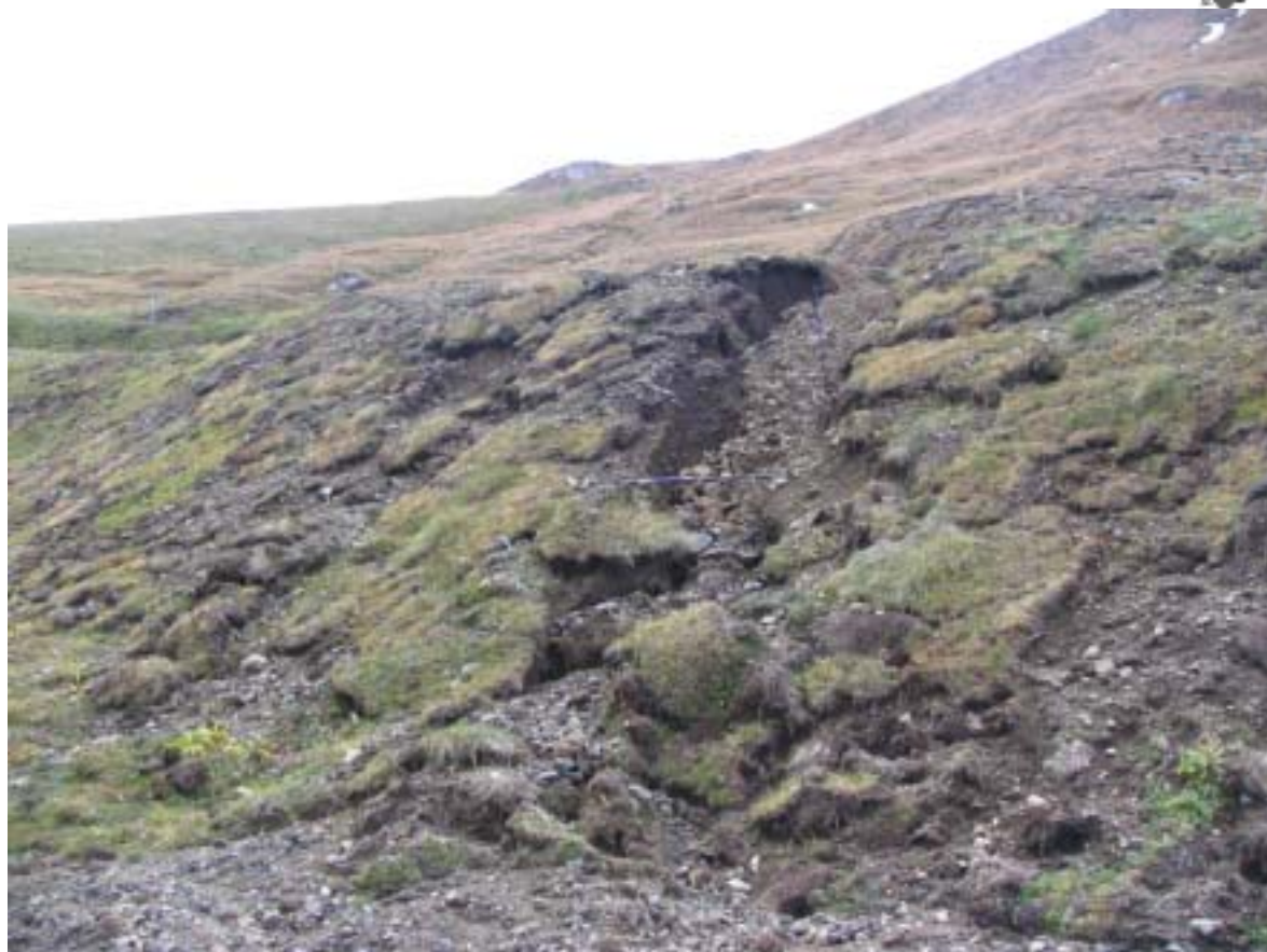
Foto 2.1) 24/9/2005 Pala del Gaigher erosione cedimento zolle
