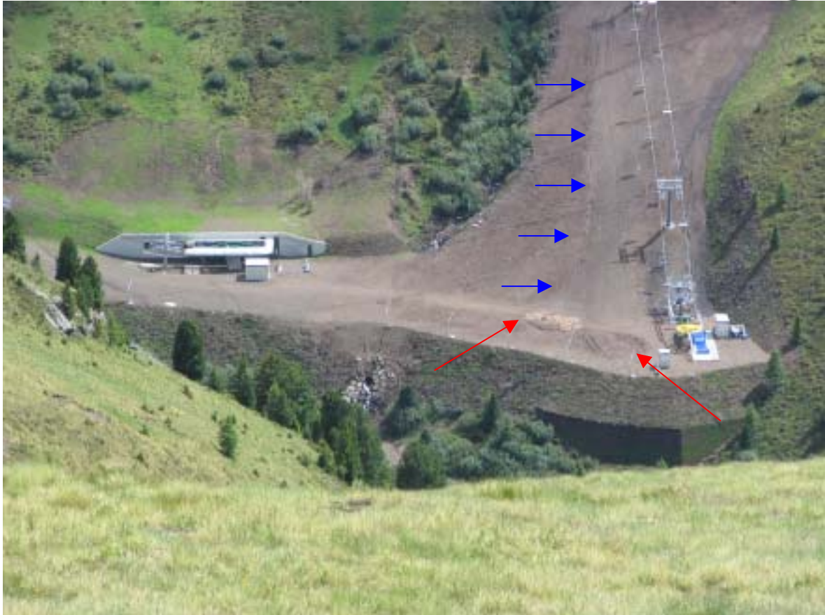
Foto 9) 2/7/2005 Fenomeno di colata di lieve entità, interessante lo strato superficiale della Pala del Geiger, visibile la zona di scorrimento e di deposito
