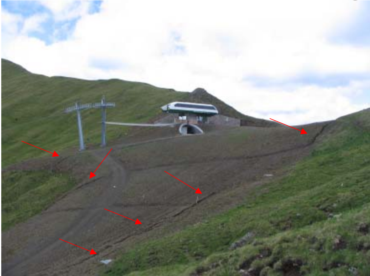
Foto 7) 2/7/2005 Sella Del Brunech; ruscellamento superficiale
