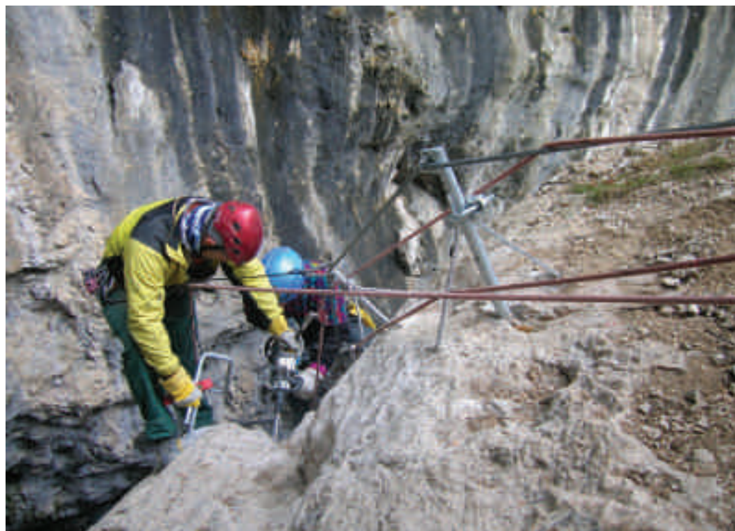
Lavori di manutenzione straordinaria della via ferrata Burrone "T. Giovanelli"
